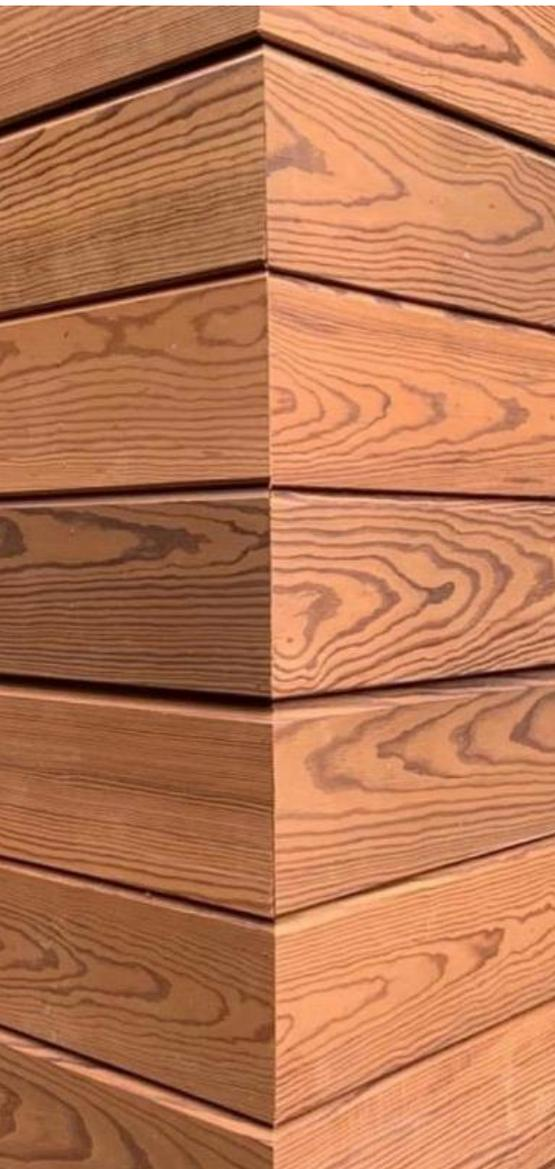
Термодревесина — это усовершенствованное дерево. Это древесина, которая прошла термическую обработку при высоких температурах (180–230°C) без добавления каких-либо химических веществ.
